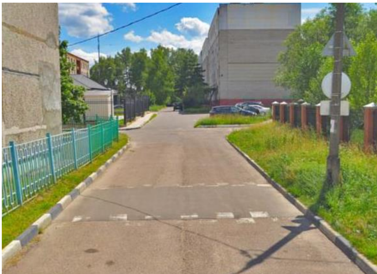
Рисунок 1.11 – Горизонтальная дорожная разметка 1.25 не соответствует требованиям ГОСТ 51256-2018
