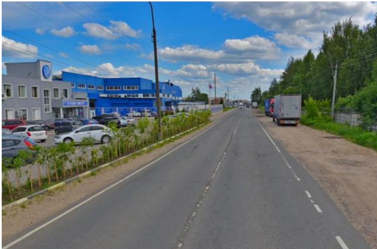
Рисунок 1.10 – Горизонтальная дорожная разметка 1.1 не соответствует требованиям ГОСТ 51256-2018
